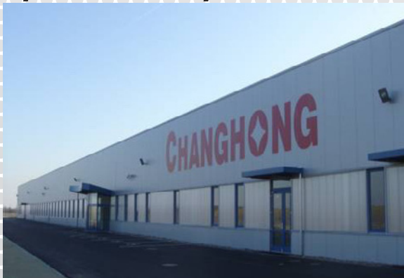
Výrobní hala Nymburk
